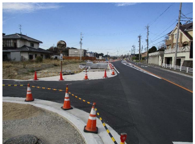
【完成に向けて施工中の和合豊田線】
