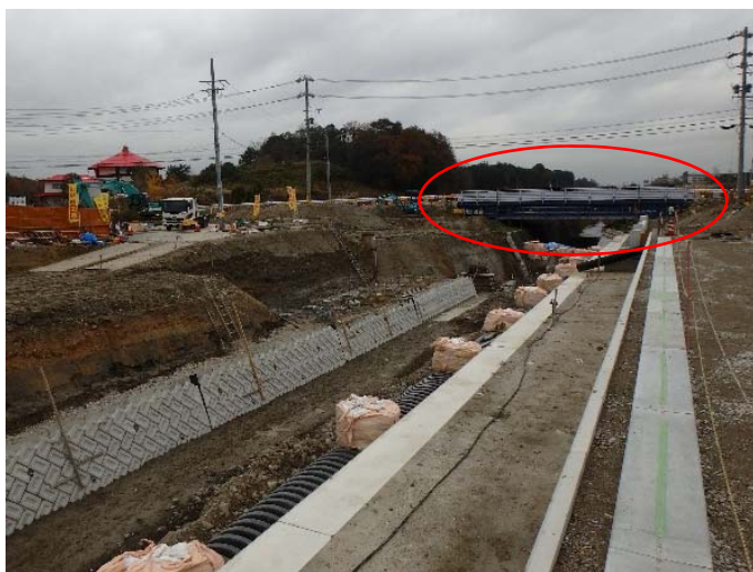
【撤去する仮橋】
