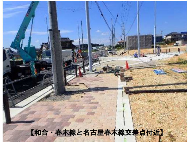
【既設アスファルトを切削し、新しいアスファルトを舗設】
