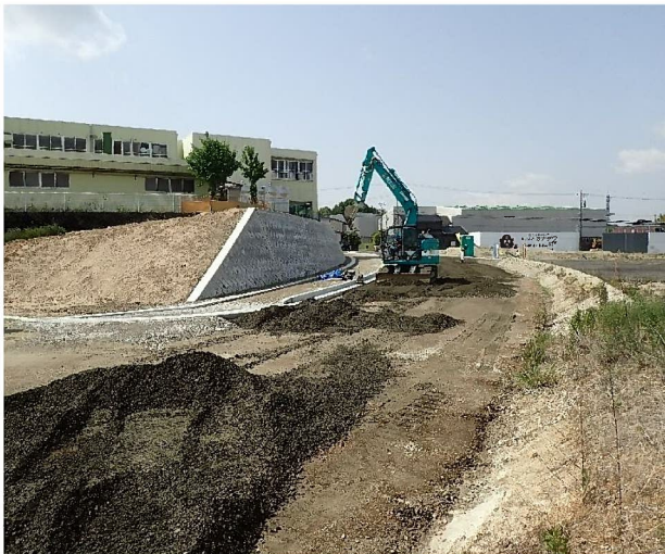
幼稚園西側道路築造
